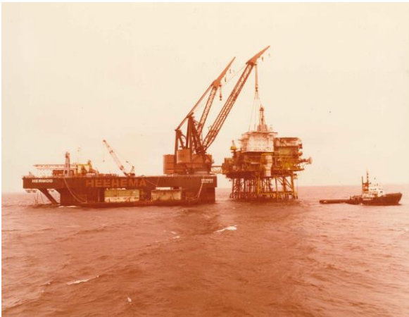
Hermod's eerste project: de installatie van het Piper A Platform in 1979
