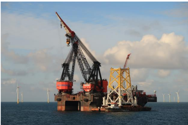
Hermod's final project: Jacket installatie voor een transformer platform voor het Borkum Riffgrund 2 windpark in juli 2017
