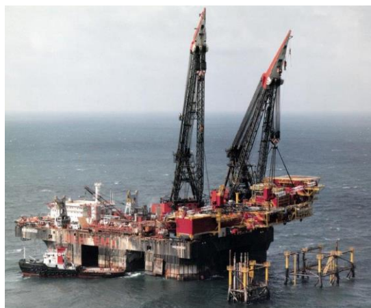
Hermod's eerste topside lift met twee kranen: Het L13 platform in de Nederlands Plat van de Noordzee in 1986
